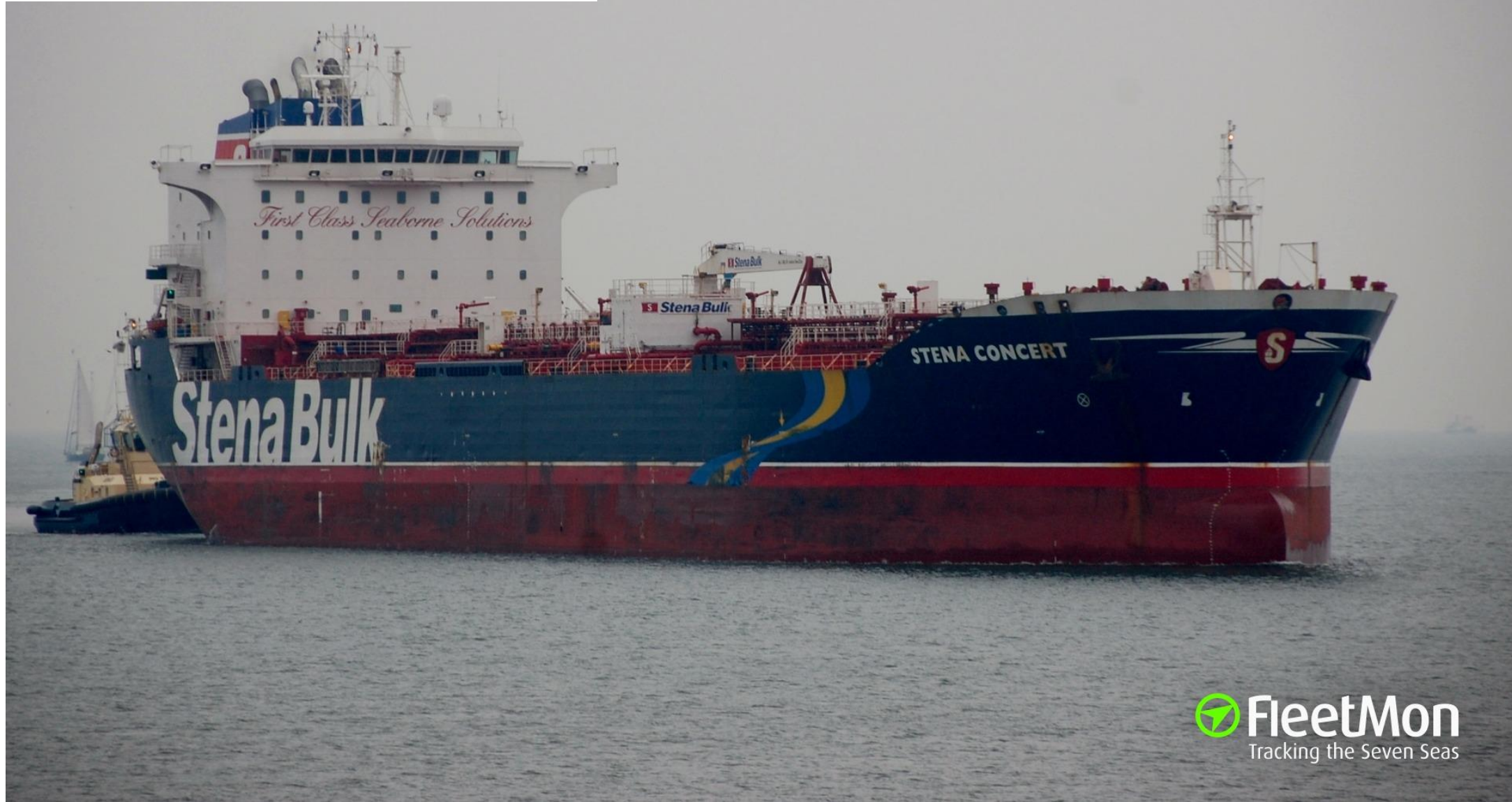
Fotografía: Módulo de tratamiento de agua de lastre sobre cubierta del buque quimiquero Stena Concert (Blue Onyx)
